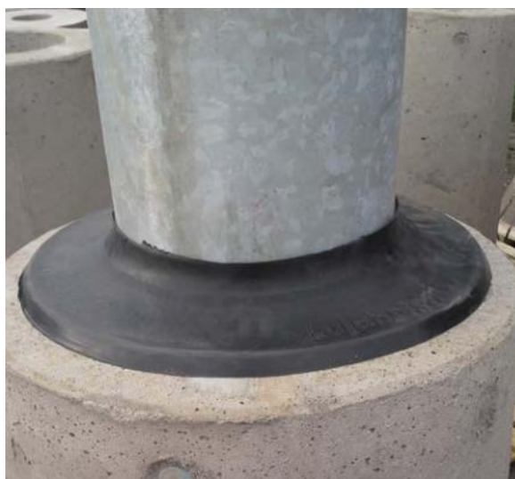
Kuva 7. Masto ja juurikumi asennettuna
