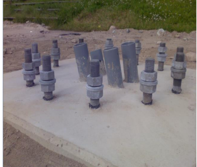
Kuva 2. Peruspultit ja johtoputket valettuna
